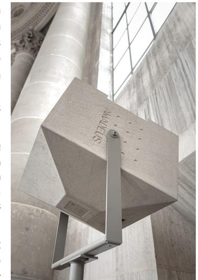
Fig. 1 : Enceinte Amadeus C15, installée au niveau de la coupole et orientée vers le vitrage. © Amadeus, SLU.
